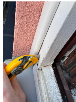
Det ble påvist områder med råteskader bak malingsbelegg
