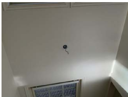
Stedvis løse ledninger som kan være strømførende.
