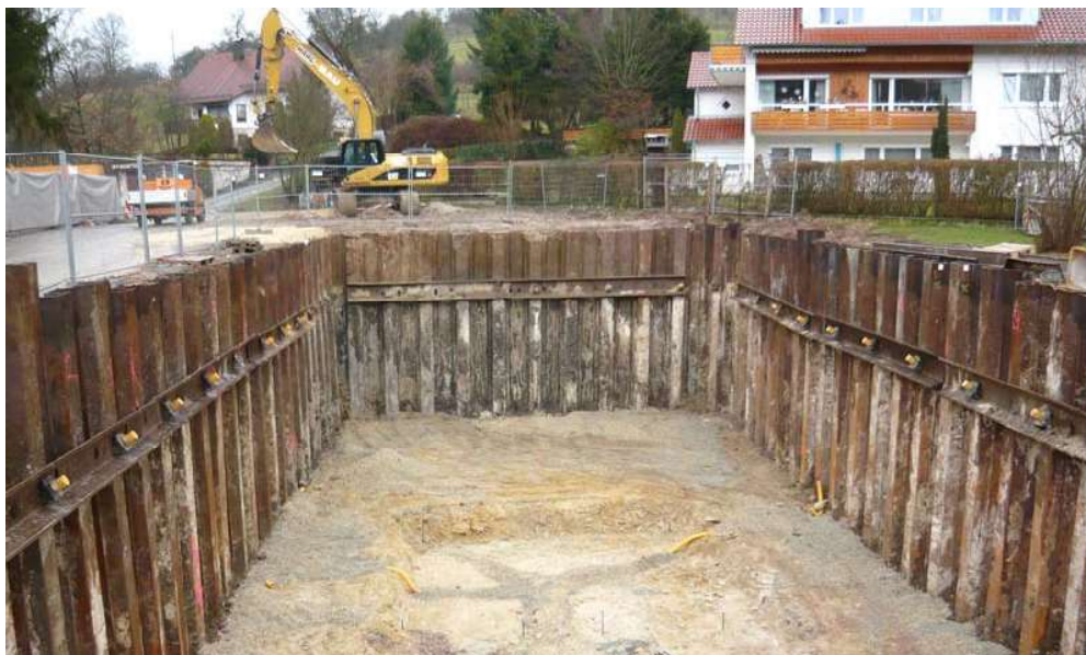
Fig.7: Eksempel på spuntavstivet byggegrop med stagforankring
