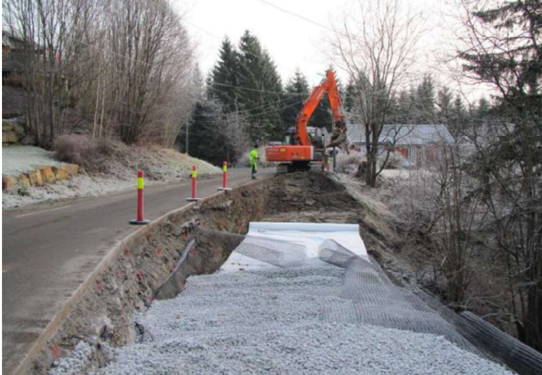
Fig. 9: Etablering av jordarmert fylling som tiltak mot setningskader på veibanen grunnet bevegelser i bratt, rasutsatt sideskråning (Foto: Statens Vegvesen)
