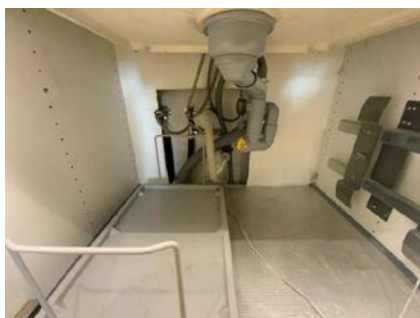
Besiktigelse av røropplegg.
