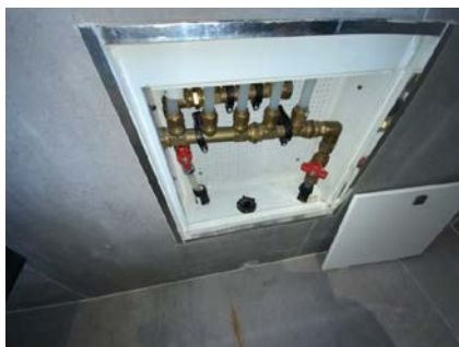
Besiktigelse av røropplegg.
