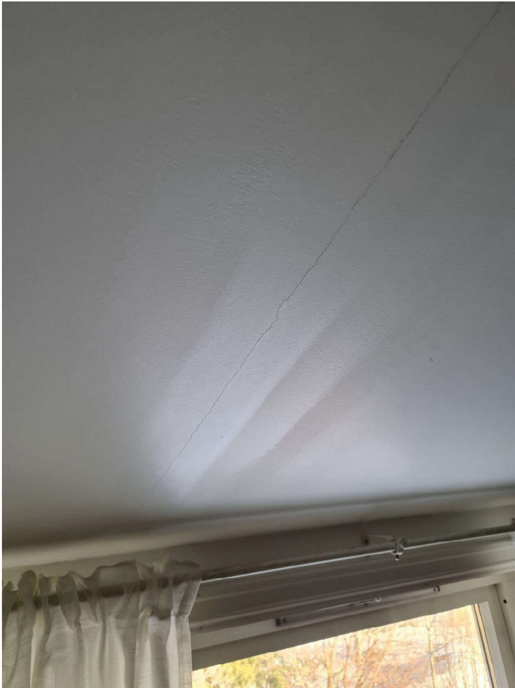
Bilde 8 – viser riss i gipsede himlinger fremstår som spenninger og dårlig håndtverk.
