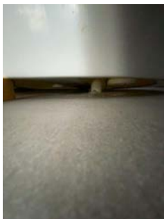
Avløpsrør ned i betongsålen under badekar.
