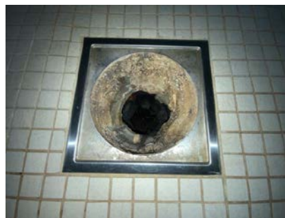
Kontroll av sluk.
