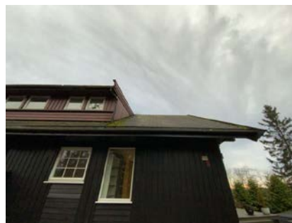
Besiktigelse av taktekke.
