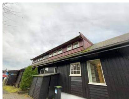
Besiktigelse av taktekke.
