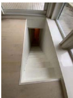
Besiktigelse av trapp ned til u.etg.
