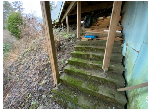
Synlige skjevheter på fundamenter.
