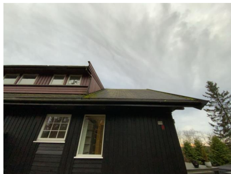
Besiktigelse av taktekke.
