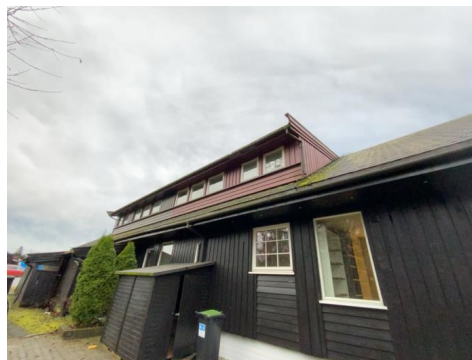
Besiktigelse av taktekke.
