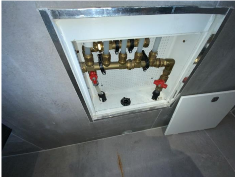
Besiktigelse av røropplegg.
