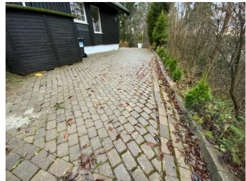
Grunn har vært i bevegelse over tid men ansees som stabilt på befaringdagen.
