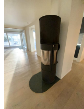
Besiktelse av ildsted. Pipeløp er bekledd med plater.
