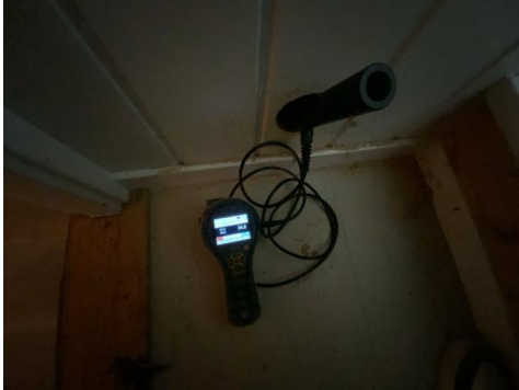
Utført hulltaking på rom under terreng.
