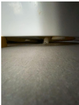
Avløpsrør ned i betongsålen under badekar.
