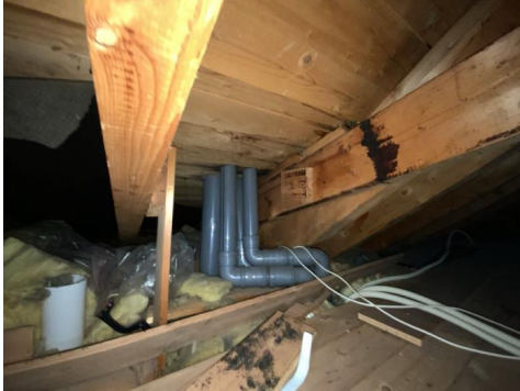
Kontroll rundt rørgjennomføringer.
