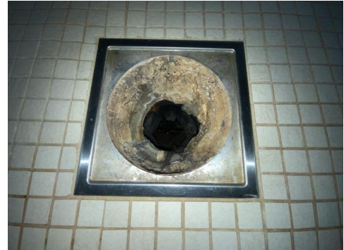
Kontroll av sluk.
