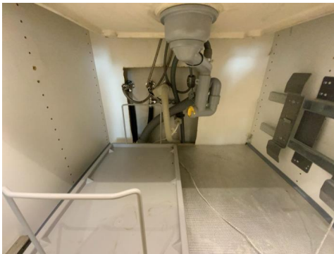
Besiktigelse av røropplegg.
