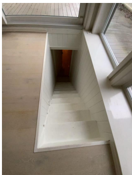
Besiktigelse av trapp ned til u.etg.
