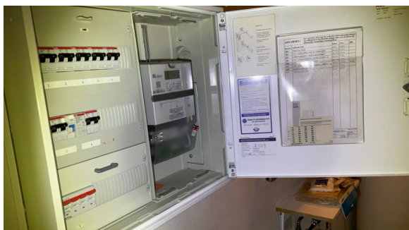
El-anlegg med automatsikringer. I hovedsak skjult ledningsnett. Sikringsskapet er plassert i bod.
