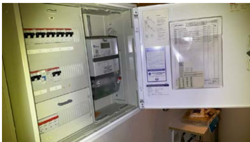
El-anlegg med automatsikringer. I hovedsak skjult ledningsnett. Sikringsskapet er plassert i bod.
