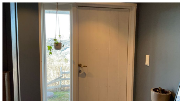
Dør i underetasje.
