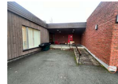
Inngangsparti til felles gang
