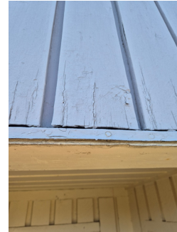
Værslitt/oppsprukket kledningsbord.
