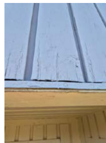
Værslitt/oppsprukket kledningsbord.
