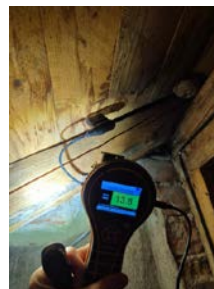
Ikke målt noe unormalt med fukt ved eldre fuktskjolder.
