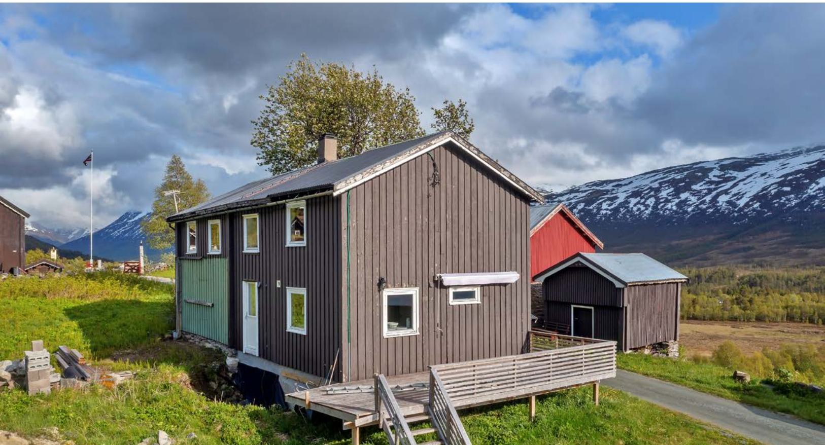
Våningshuset er antatt oppført i 1938 og tilbygget i 1972
