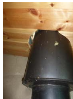
Viser utetthet/dagslys rundt pipe sett fra kjøkken.
