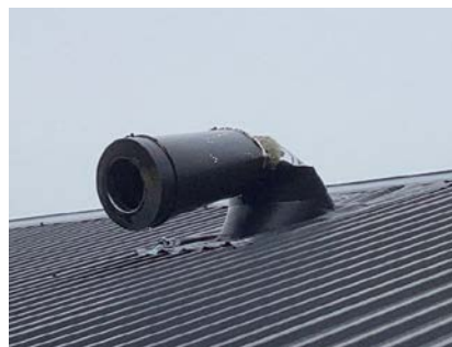
Viser stålpipesnekt over tak.
