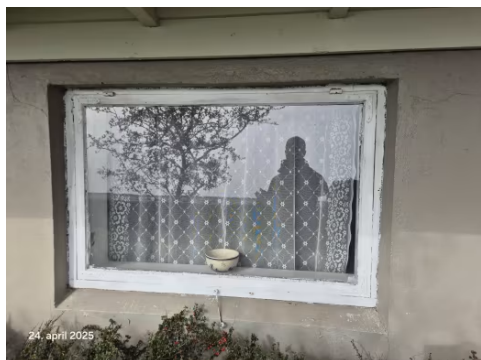
Vindu med 1-lags glass inn til underetasjen.
