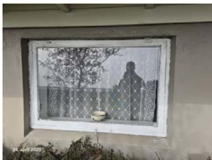
Vindu med 1-lags glass inn til underetasjen.
