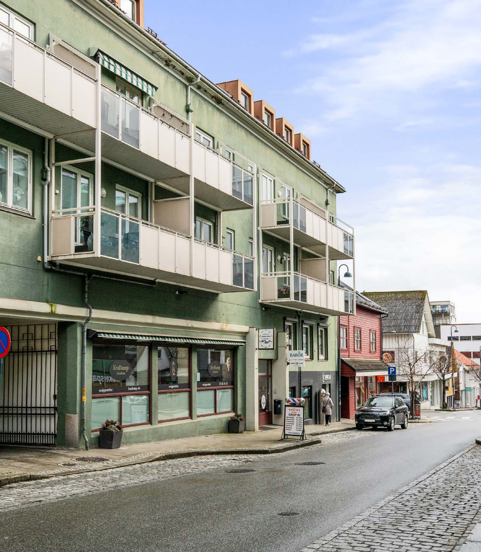
Inngangsparti ligger i sørdenden av bygget
