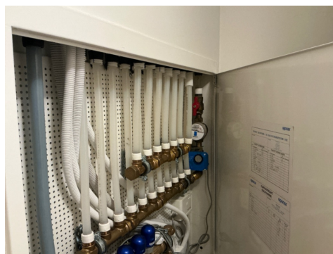
Fordelerskap plassert i bod/teknisk rom
