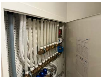
Fordelerskap plassert i bod/teknisk rom
