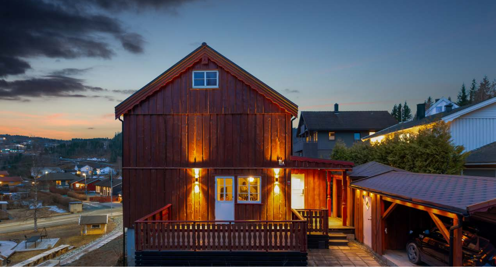
Utvendig har boligen villmarkskledning fra 2006 og nytt yttertak fra 2020.
