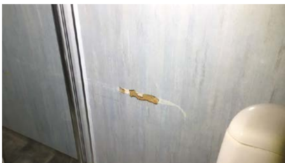
skader i våtromsplate
