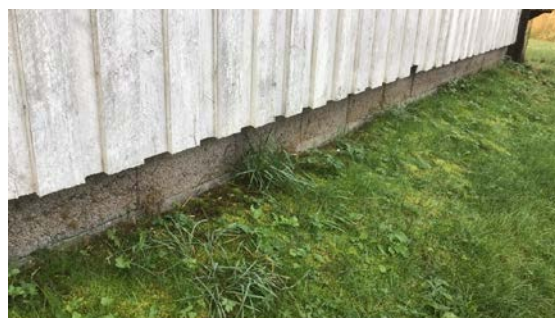
Synlig leca på tilbygget
