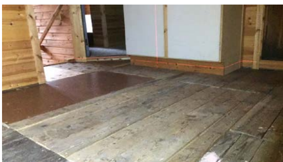
Gulv i gang på loft
