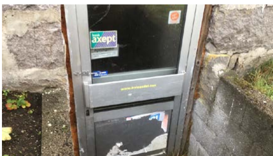
Utettheter mellom dørkarm og mur
