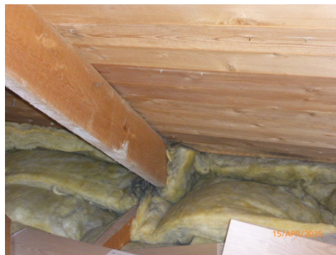
Helt åpent mellom boenhetene på kaldt loft.
