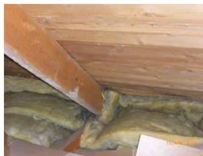
Helt åpent mellom boenhetene på kaldt loft.
