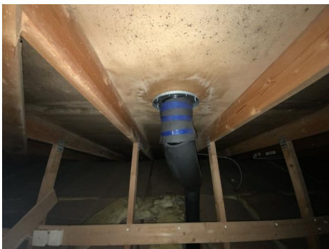
Kontroll rundt rørgjennomføringer.
