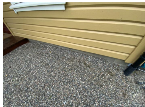
Kontroll av drenering.
