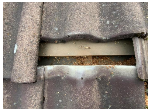
Kontroll av undertak.
