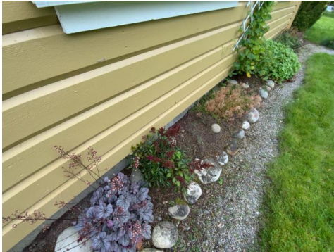
Kontroll av drenering.
