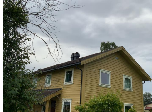
Besiktigelse av taktekke.
