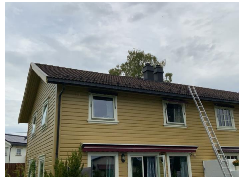
Besiktigelse av taktekke.
