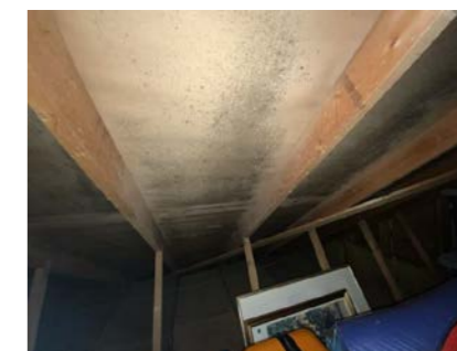
Saneringsvask av overflater bør utføres.
