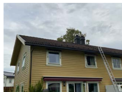
Besiktigelse av taktekke.
