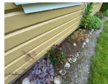
Kontroll av drenering.
