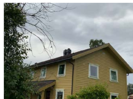
Besiktigelse av taktekke.
