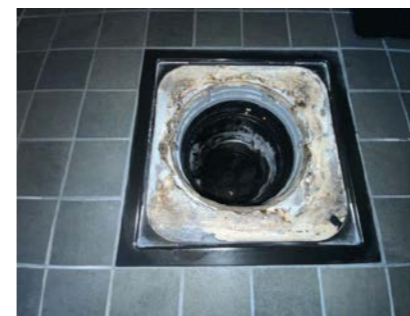
Kontroll av sluk.
