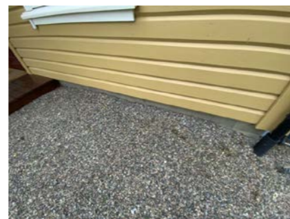
Kontroll av drenering.
