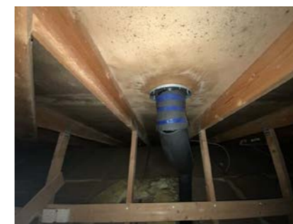
Kontroll rundt rørgjennomføringer.
