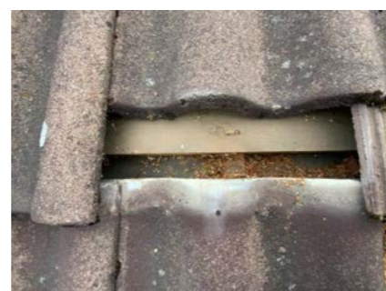
Kontroll av undertak.
