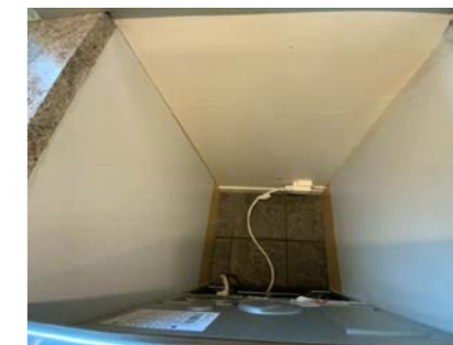
Kontroll bak ovn. Ingen tegn til fuktskader på befaringdagen.
