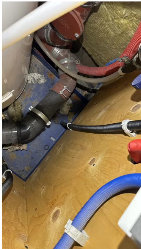
Ingen registrert fukt ved inspeksjon av nisje.
