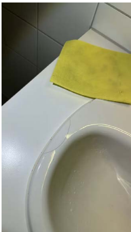
-Sprekk i servant.
