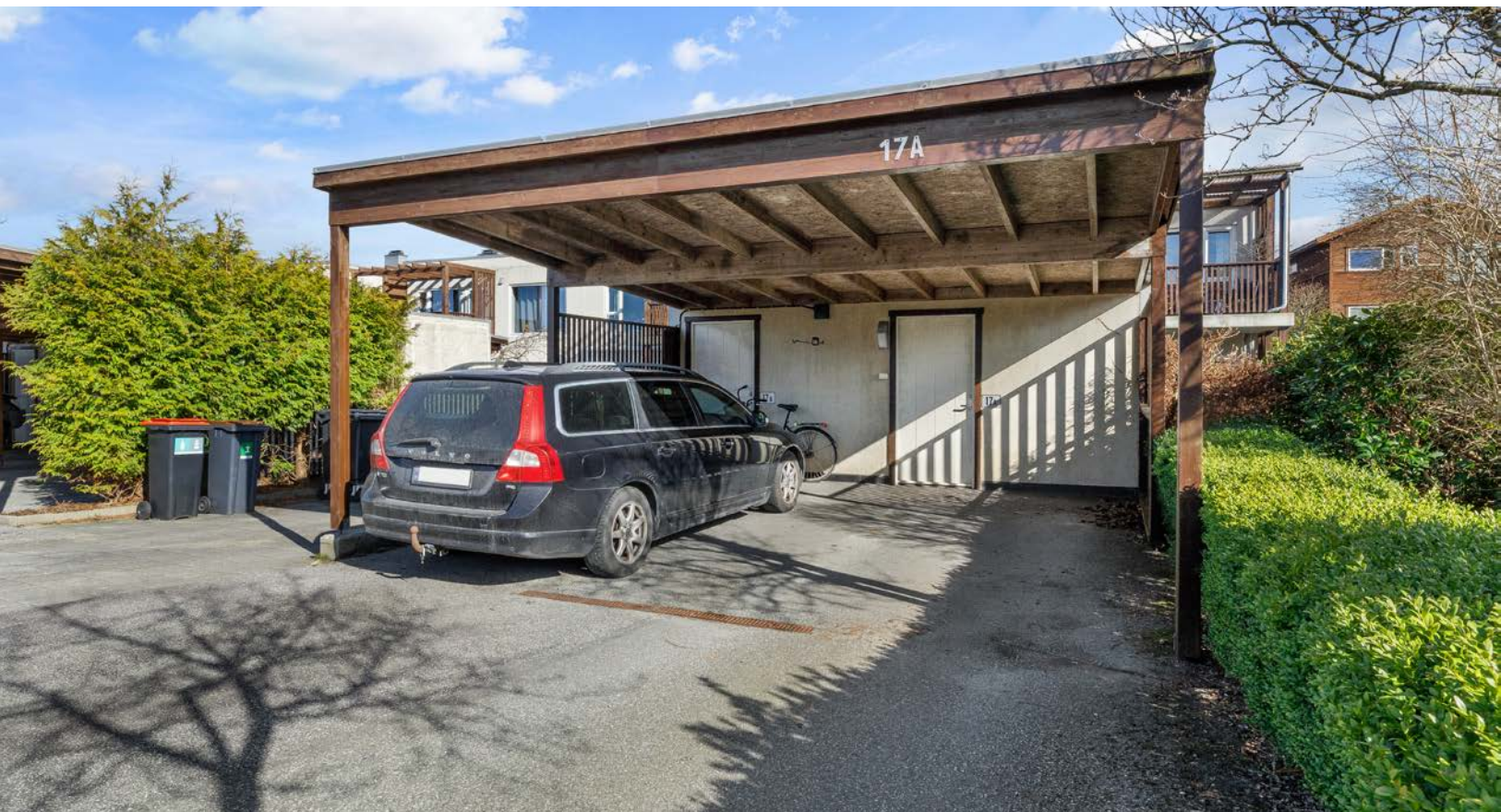
Parkering i carport, samt en parkeringsplass fremfor carport - sportsbod i ende av carport
