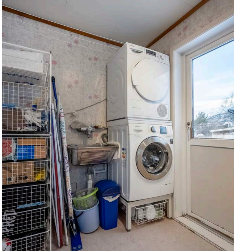
Vaskerom med skyllekar og opplegg for vaskesøyle
