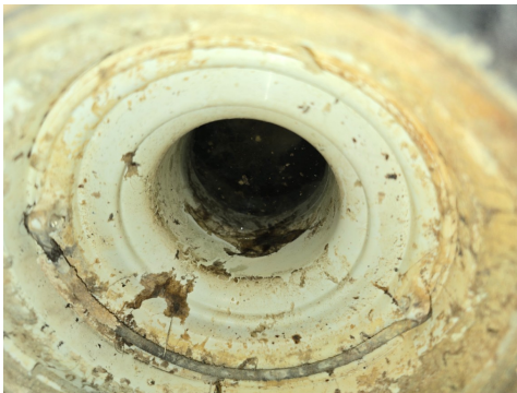
Bild av sluk under dusj.
