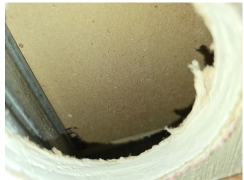
Bildet viser hulltaking mot dusj.
