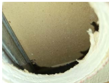
Bildet viser hulltaking mot dusj.
