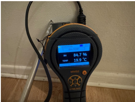
Måling av relativ luftfuktighet.
