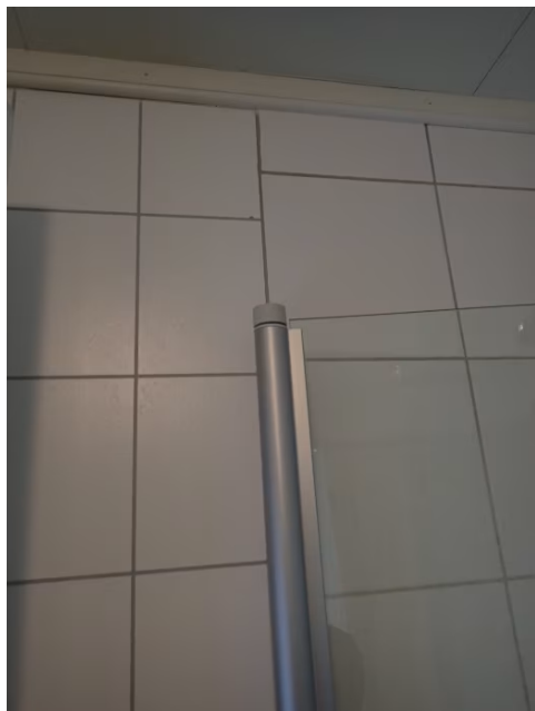
Overgang mellom flis og våtromsplater
