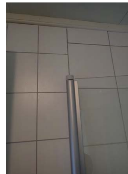
Overgang mellom flis og våtromsplater
