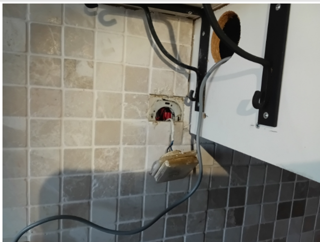
Gammelt wattmeter og koblingsboks kjøkken. Wattmeter er ikke i bruk. Samt at vegglokk over koblingsboks mangler
