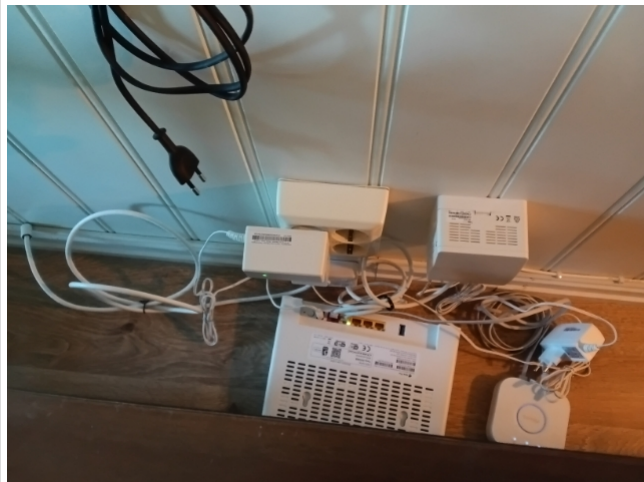
Stikkontakt veranda. Mangler jordforbindelse.
