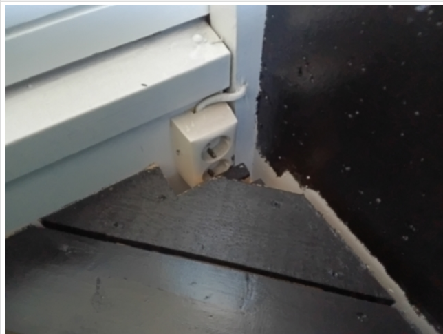
Stikkontakt veranda. Mangler jordforbindelse.
