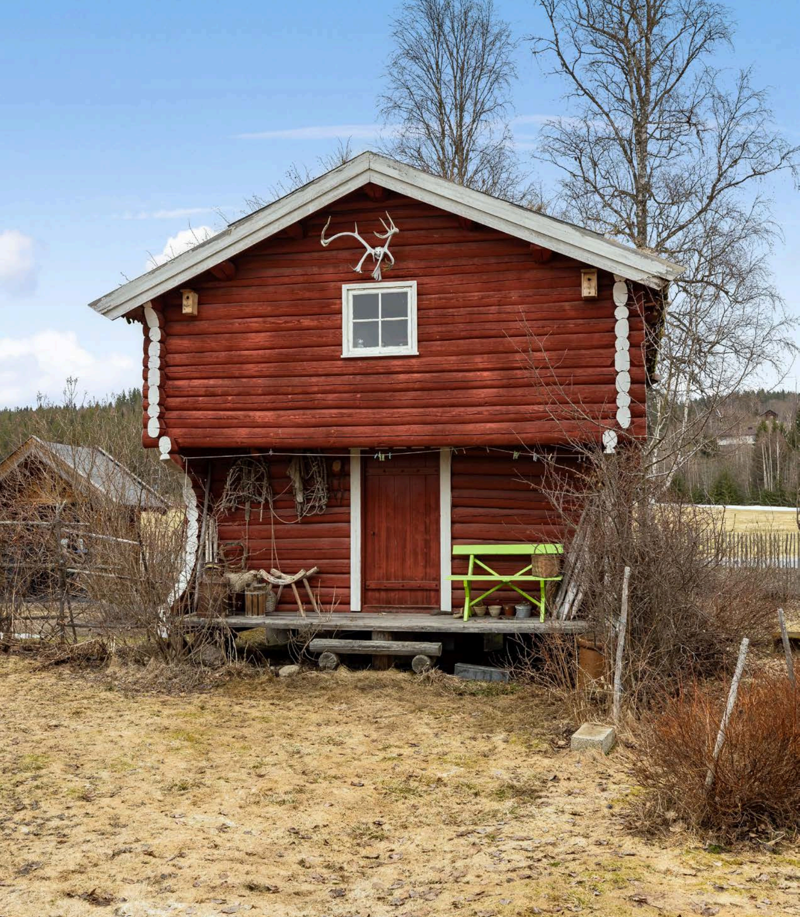
Stabbur over 2 etasjer fra ca. 1941. Stabburet har yttervegger i laft og torvtak.
