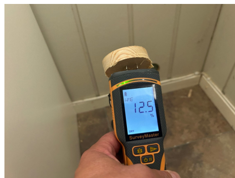
Fuktmåling i kjeller.
