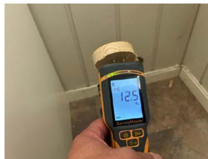
Fuktmåling i kjeller.
