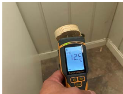
Fuktmåling i kjeller.
