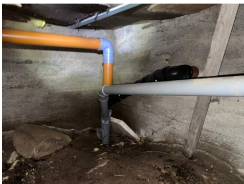
Avløpsrør krypkjeller
