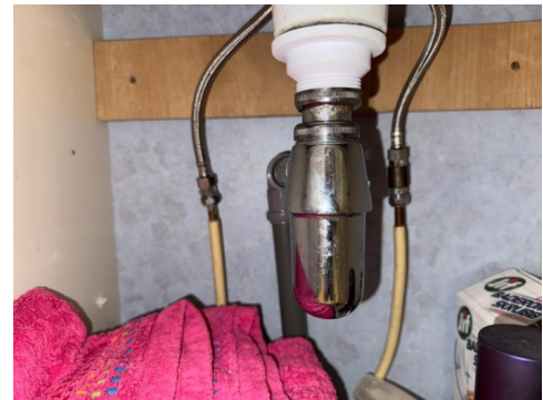
Røropplegg bad 2. etg.
