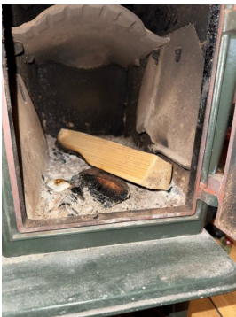
Avstand fra fremkant ovn til brennbart materiale/gulv 26,5 cm.
