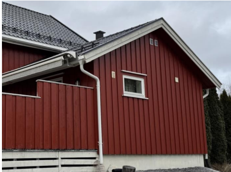
Ukjent takkonstruksjon på tilbygg
