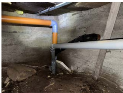
Avløpsrør krypkjeller
