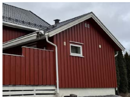
Ukjent takkonstruksjon på tilbygg
