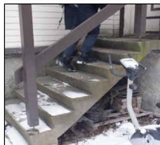
Trappeløp 3; utvendig fra internttrapp 3. etg. Betong.
