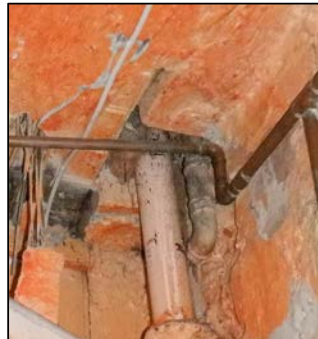
Gjennomføring i kjeller
