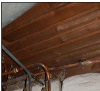
Himling i kjeller med panel.
