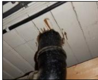
Gjennomføring i kjeller
