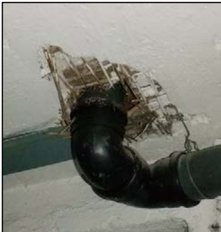
Gjennomføring i kjeller
