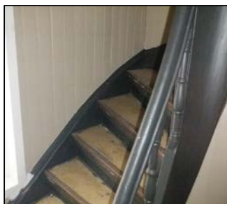
Trappeløp 2; internttrapp fra loft og til 1. etg. Tre.
