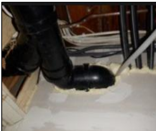
Gjennomføring i kjeller
