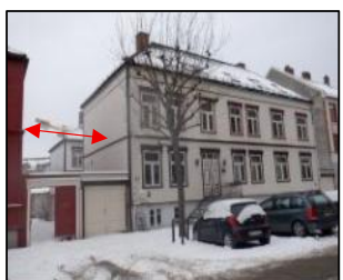
Til nr. 80A er det kun 5m avstand. Både vegg i 80A samt i 82A fremstår uten vinduer e.l.
