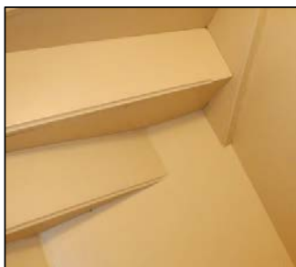
Trappeløp 1; fra 2 etg og til utgangsdør.
