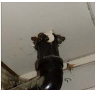
Gjennomføring i kjeller
