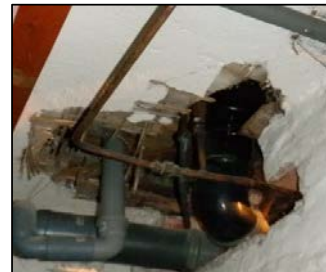
Gjennomføring i kjeller
