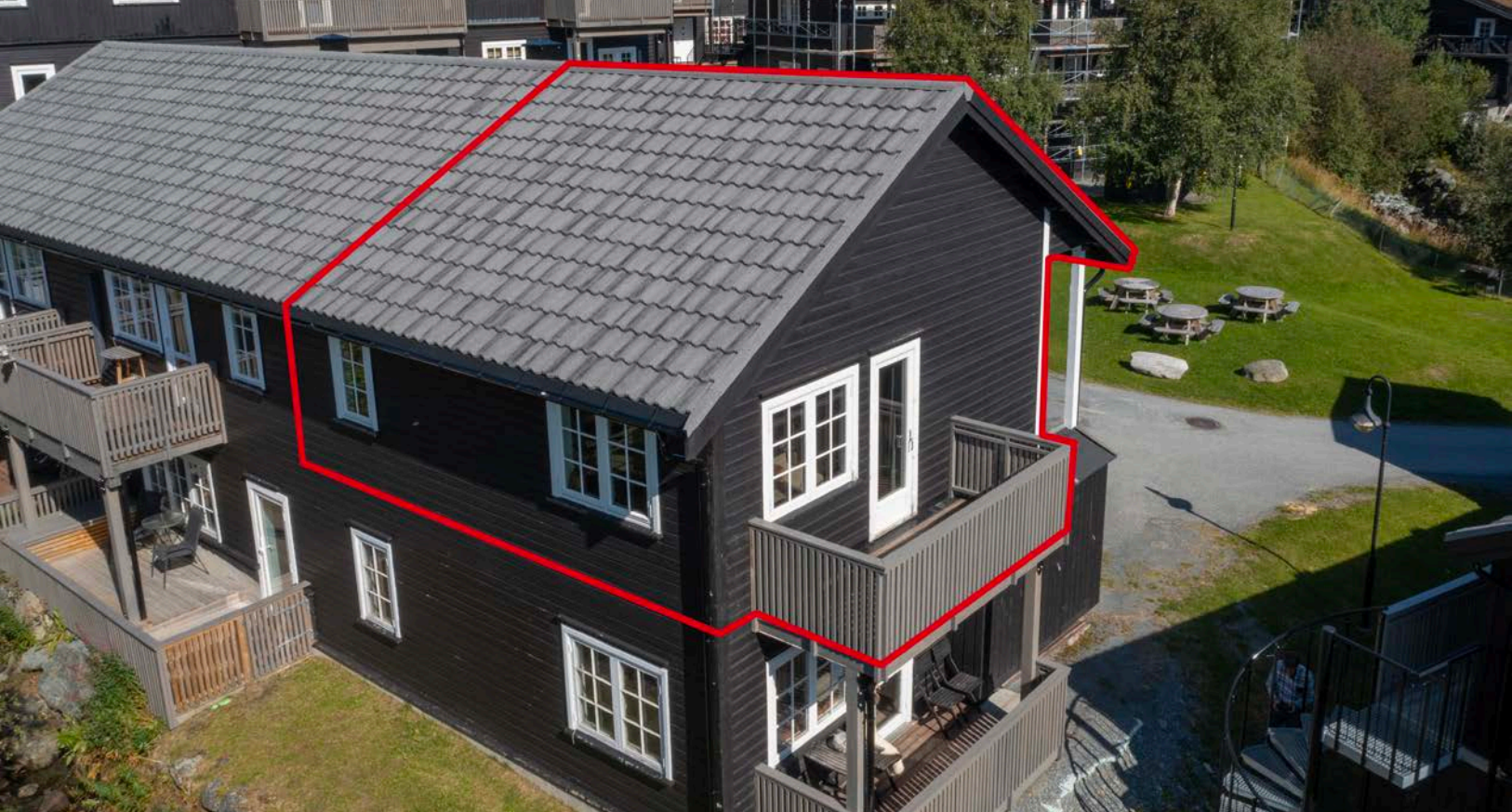
Fasade med markering
