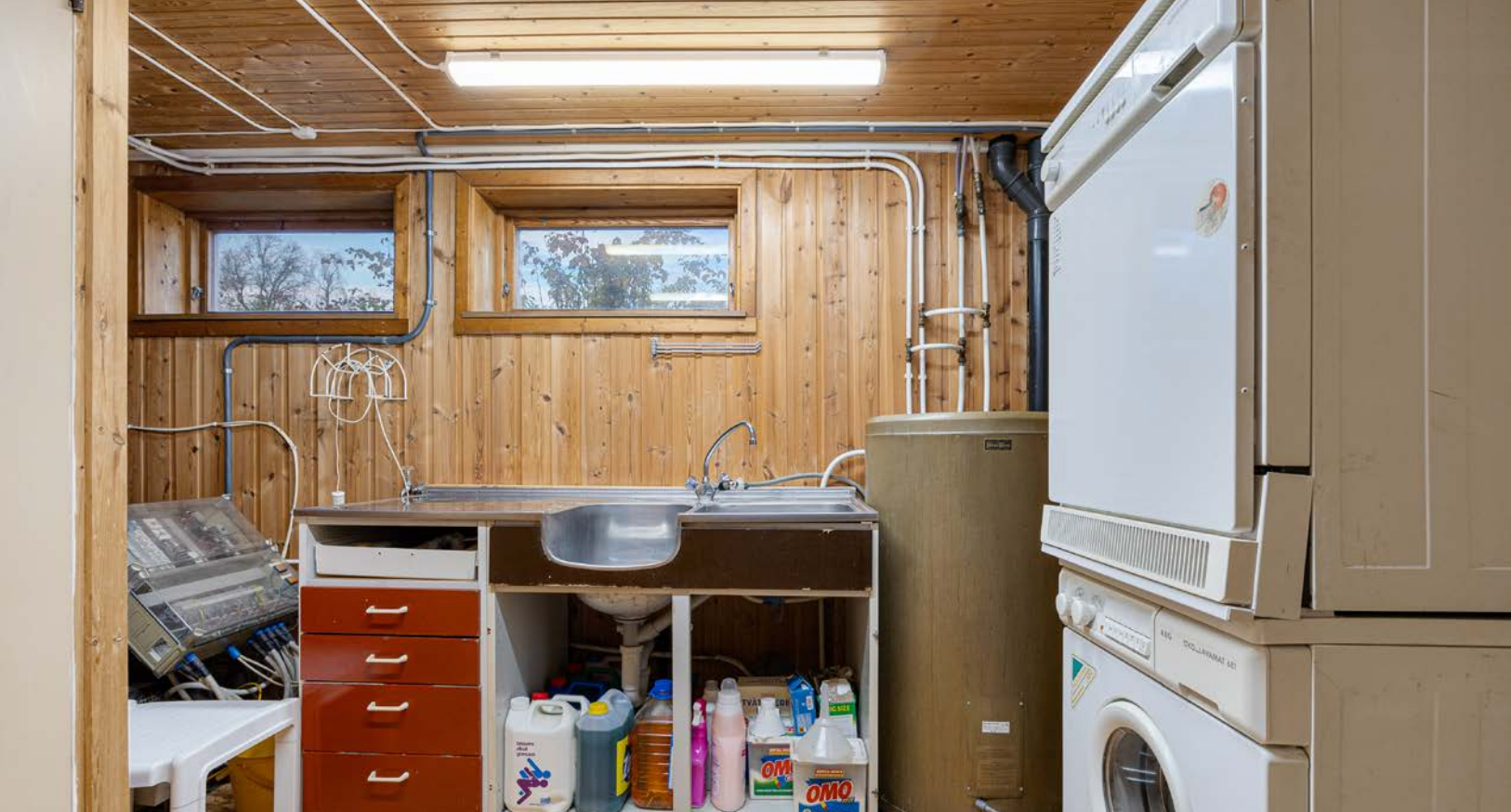
Vaskerom/teknisk rom i kjeller har plass til vaskemaskin og tørketrommel i vaskesøyle.
