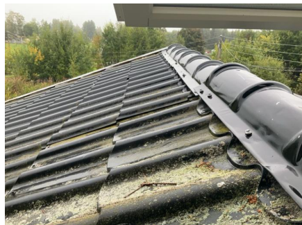
Tak på tilbygg mot nord.
