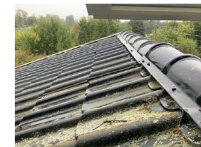
Tak på tilbygg mot nord.
