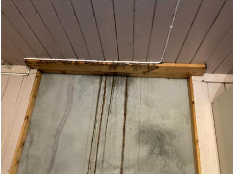
Rennermerke på pipe i loftetasje.
