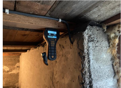
Fuktmåling i bjelkelag viste ca. 16 % fukt, som er normalt.
