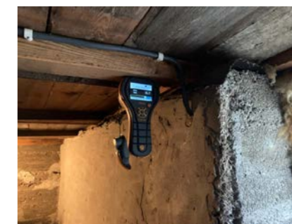
Fuktmåling i bjelkelag viste ca. 16 % fukt, som er normalt.
