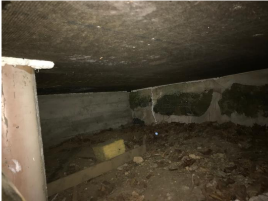
Stubbloft under del av stue.
