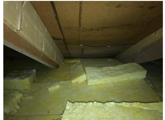
Luftespalte tett med isolasjon over tilbygg
