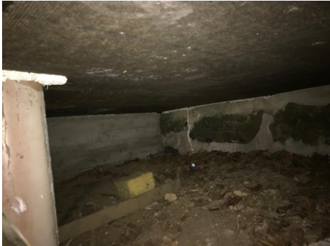
Stubbloft under del av stue.
