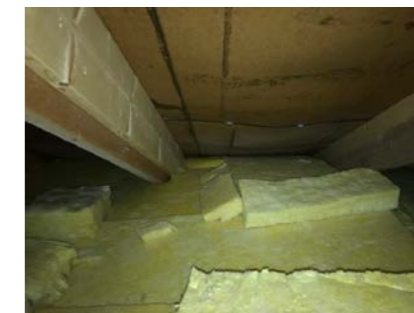
Luftespalte tettet med isolasjon over tilbygg
