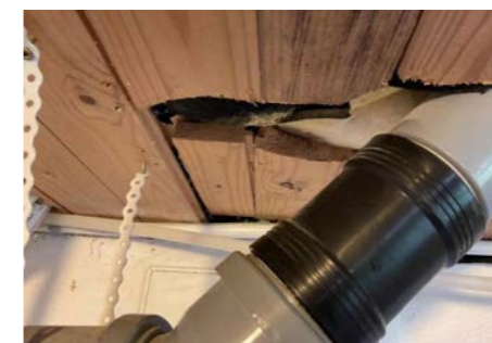
Avløpsrør fra bad 1.etg. Synlig bjelkelag.
