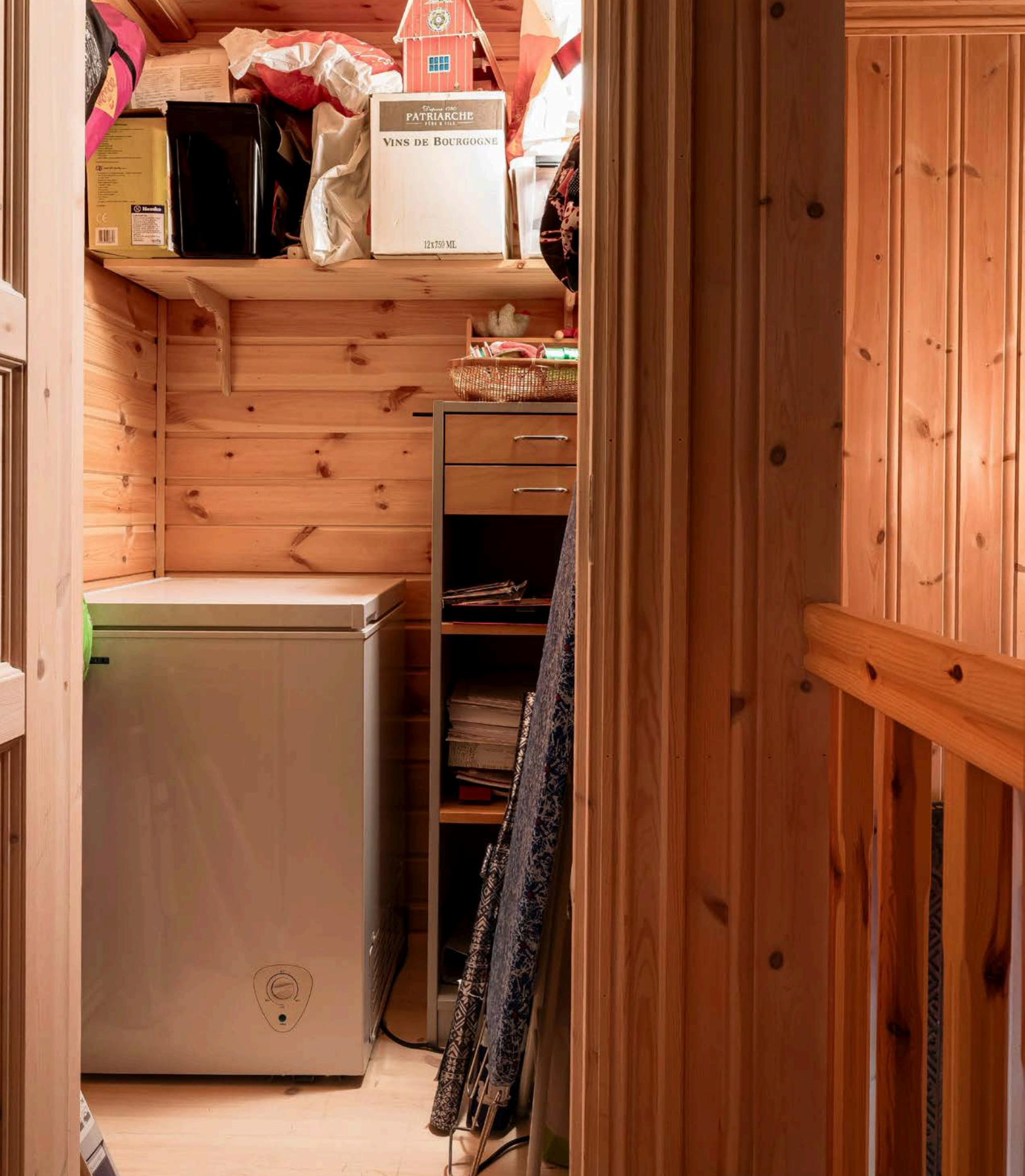
Vegg-i-vegg med badet i første etasje er det en praktisk bod/teknisk rom med fin lagringsplass. Rommet huser ellers vv-bereder, sikringskap og fordelingskap for rør.
