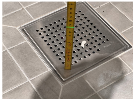
Fallforhold ca. 134 mm topp slukrist i dusjsone
