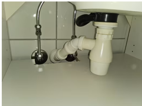
Leiligheten har synlige avløpsrør av plast.
