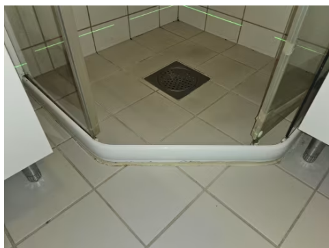
Sluk er isolert inne i dusjsonen.
